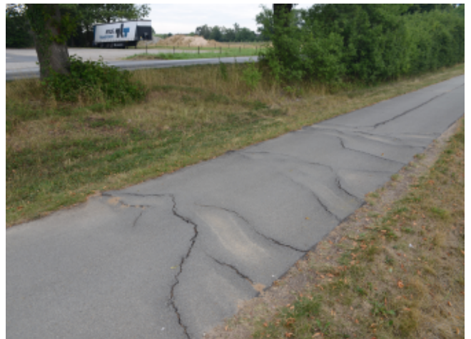
Bild 2.3.06, Sonderprüfung und langer Riss in der Mitte
