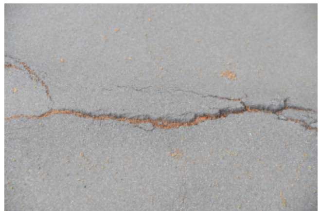
Bild 2.3.03, Plattentektonik oder Grabenbruch? Ein Streiflicht würde die Aufwölbung sichtbar machen.
