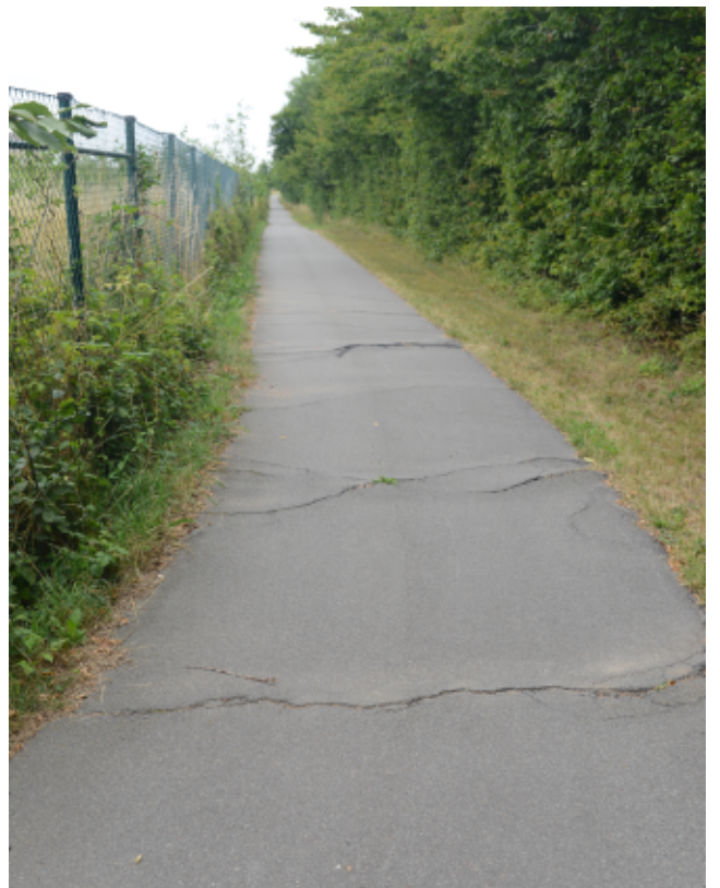
Bild 2.3.06, Sonderprüfung und langer Riss in der Mitte
