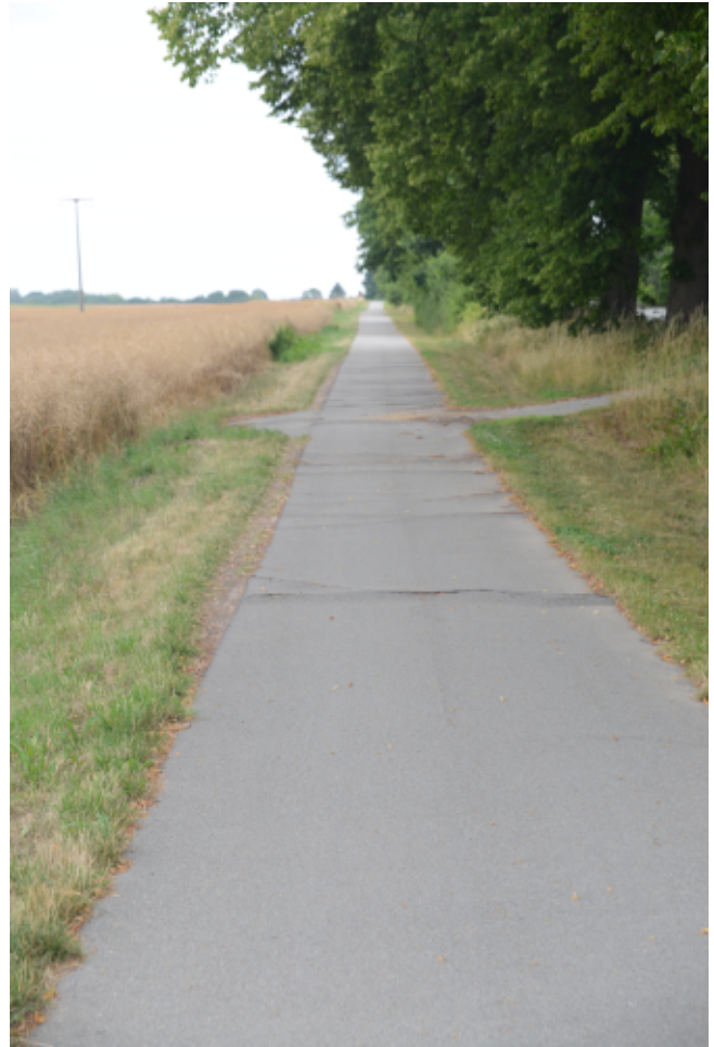
Bild 2.3.02, an Position 4, durch Wurzeln angehoben. Deutlich sichtbar die Spuren der Ausweichmanöver über den unbefestigten Seitenstreifen links.
